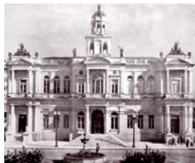
FIG.4 Fachada do Paço dos Açorianos, Porto Alegre Projeto de João Antônio Luiz Carrara Colfosco (1899-1901) Imagem: Déc. 1920 (Arquivo Particular).
